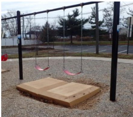
primer vgradnje plošč pod gugalnico
