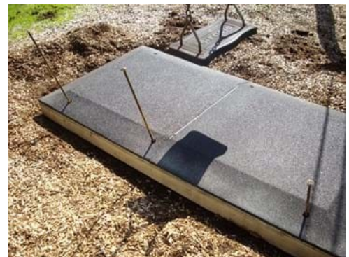
primer vgradnje plošč pod gugalnico
